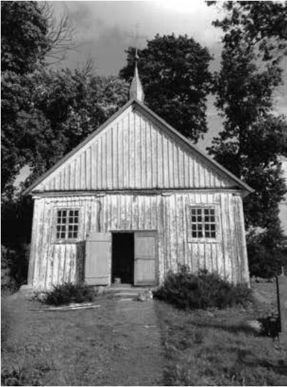
Salamiesčio bažnytelė prieš remontą
