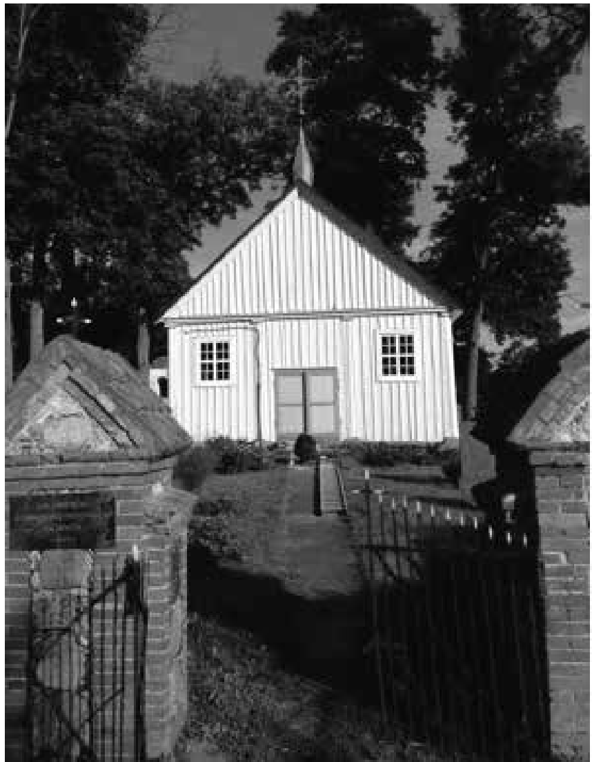
Salamiesčio bažnytėlė po remonto
