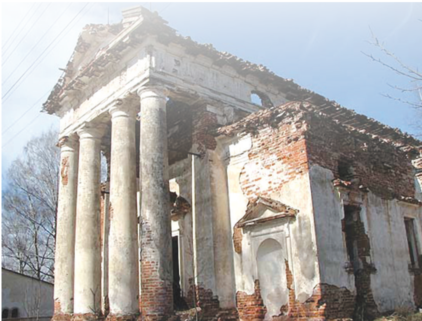
Rasnos reformatų bažnyčios griuvėsiai
