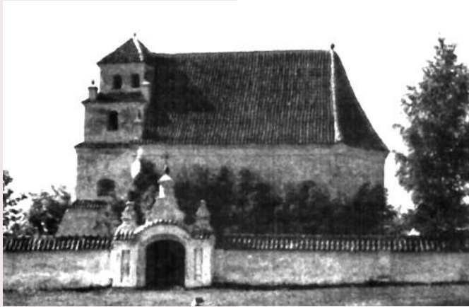
Ostašino buv. reformatų bažnyčia, XIX a., Baltarusija
