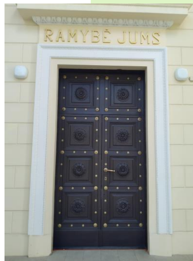
Restauruotos Vilniaus reformatų bažnyčios durys
