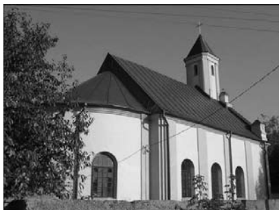
Izabelino buv. reformatų – liuteronų bažnyčia, dabar katalikų Apaštalų Petro ir Povilo bažnyčia, Volkovysko raj., Gardino sritis.
