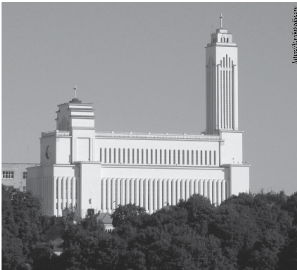
Kristaus Prisikėlimo bažnyčia – didžiausia monumentalios architektūros bazilikinė bažnyčia Baltijos šalyse. Architektas K. Reisonas
